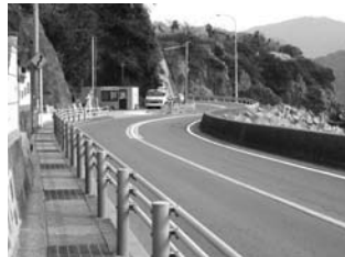
国道202号の歩道の状況(福田本町)
