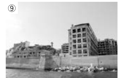
⑨ 見学通路や広場などの整備工事が進められている端島
