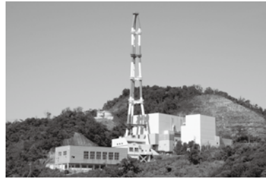
建替計画が検討されている西工場
