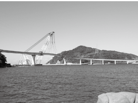
(仮称) 伊王島大橋架橋状況
