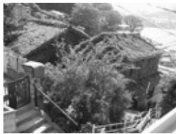
老朽危険空き家除却前
