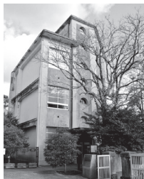
▲城山小学校被爆校舎 携して準備を進めている。
