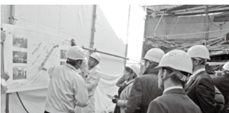
▲銅座市場崩落後の状況を調査
