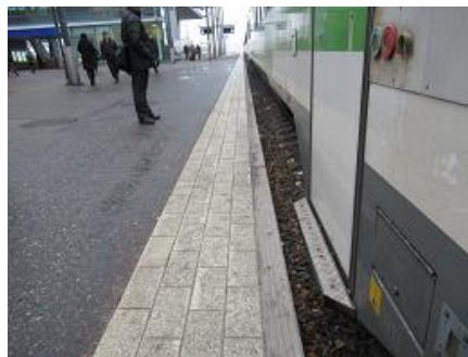
列車の入り口、ホームと同じ高さ
