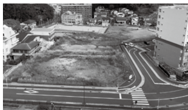
▲大園市営住宅跡地
