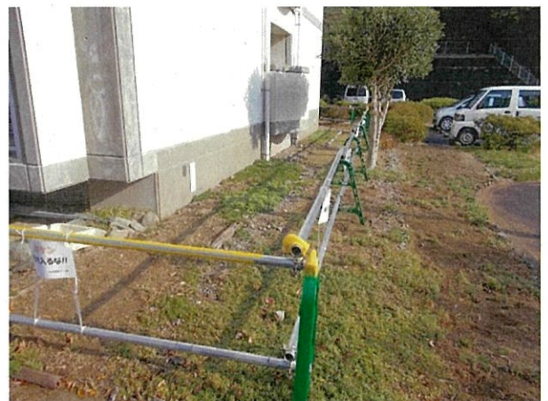
安全対策状況
