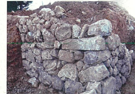
C-3 敷地の石垣（南側） 全部移動
