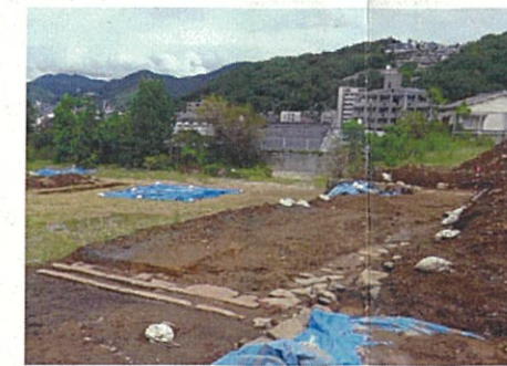
B 建物の礎石及び雨落ち溝 一部移動
