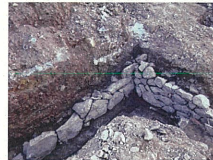
C-2 敷地の石垣（南側） 全部移動
