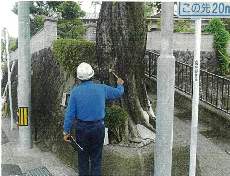
樹木医による 打音検査の状況
