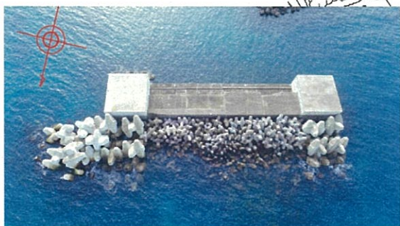
沖防波堤現況写真
