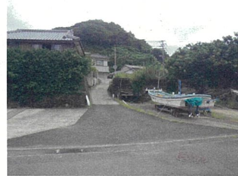
漁業集落道現況写真
