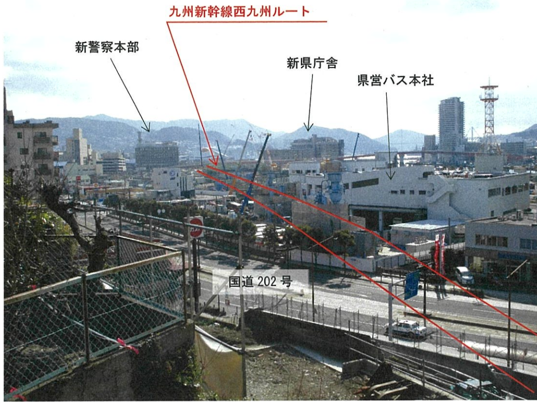
天神町（建物解体中現場付近）から新駅舎側を望む
