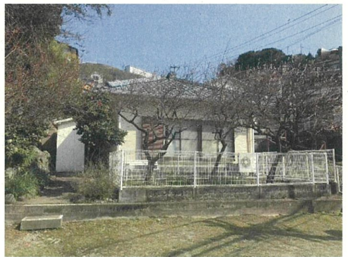
天神町公民館 (エアコン取替)
