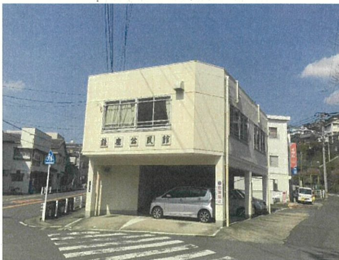
銭座公民館 (外壁改修、看板改修、タラップ設置)
