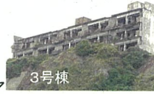
【H36~】3号棟: 景観形成に貢献しかつ代表的な居住施設遺構であり劣化度から補修の延命効果を見込む
