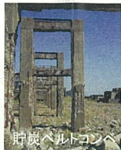
【H34~37】ドルシクナー、【H33~36】貯炭ベルトコンベア、【H37~】積込みコンベア: 選炭、貯炭、積込という石炭運搬の流れが理解できる遺構
