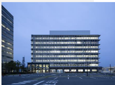
熊本合同庁舎B棟
