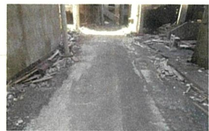
図11 現状の管理用道路
