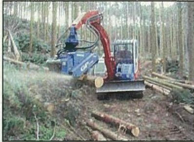
間伐作業（既存補助）山林整備事業
