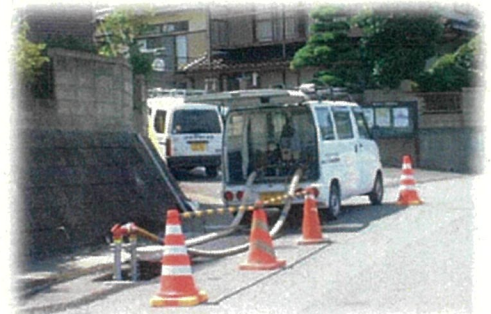
漏水調査をしている様子
