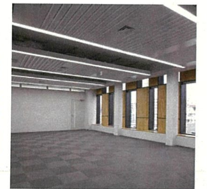
輻射パネルの例
