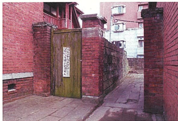
⑤-3 職員住宅北側仕切石塀
