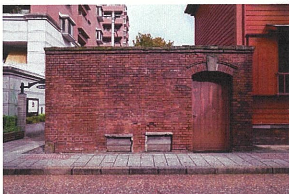
⑤-2 南西隅煉瓦塀
