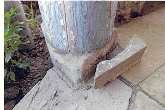
ベランダ柱基礎石
