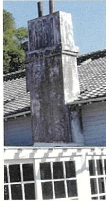
煙突部現況写真
