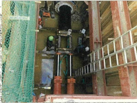
パイプインパイプ施工状況（参考）
