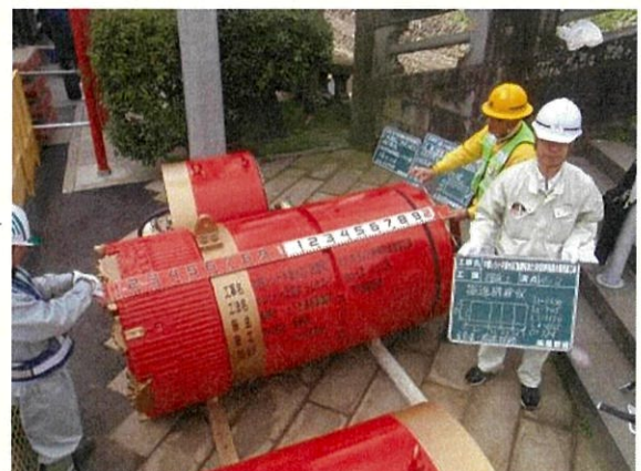
H25年度施工時の掘進機
