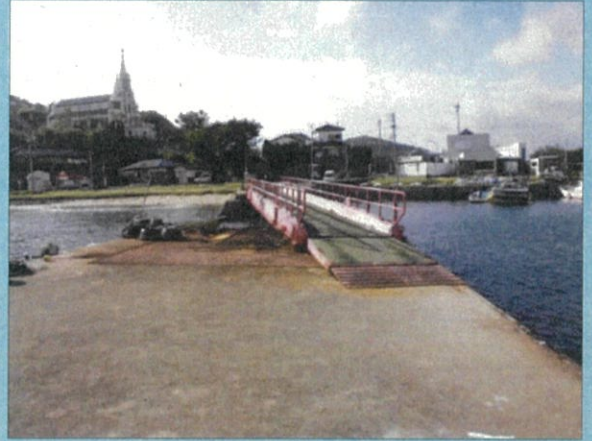
③ 棧橋ずれ状況
