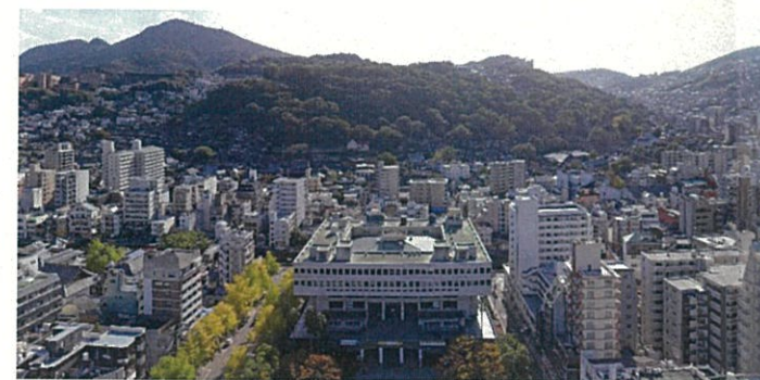
東側(市民会館側) 風頭山、寺町を望む
