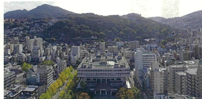
【東側(市民会館側) 風頭山、寺町を望む】
