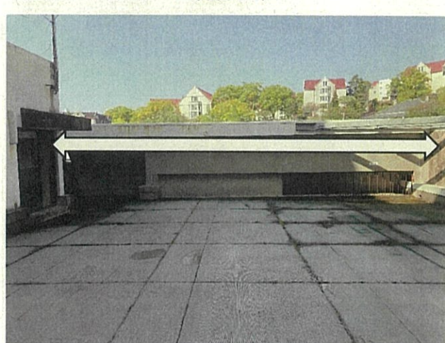
<屋上小口部分 石綿除去>
