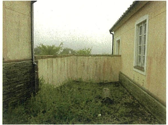
街のエリア（②トイレと店舗の間）
