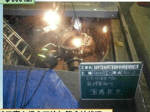
不断水（断水せずに配水管の分岐工事を行う工法）管分岐状況
