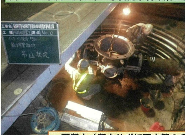
不断水（断水せずに配水管の分岐工事を行う工法）管分岐状況
