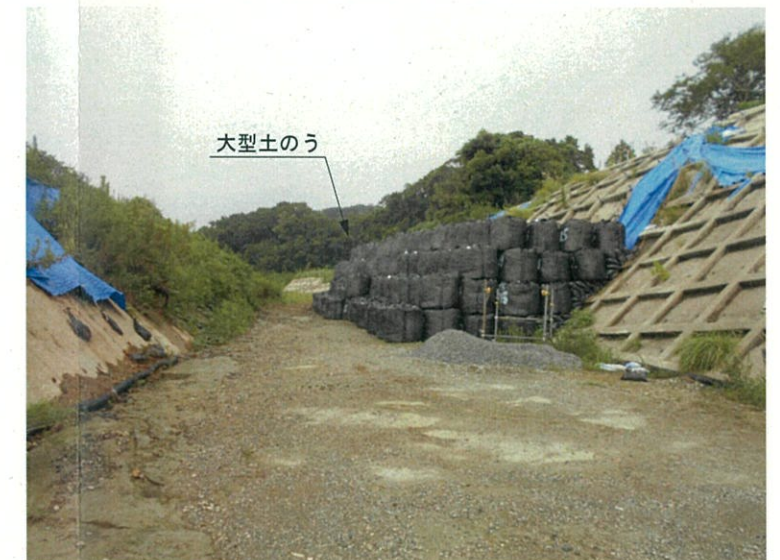
R1.7 大型土のう設置状況
