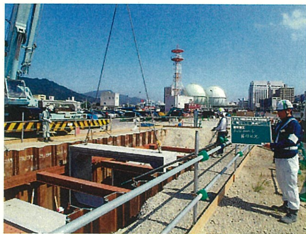
雨水貯留管据付状況
