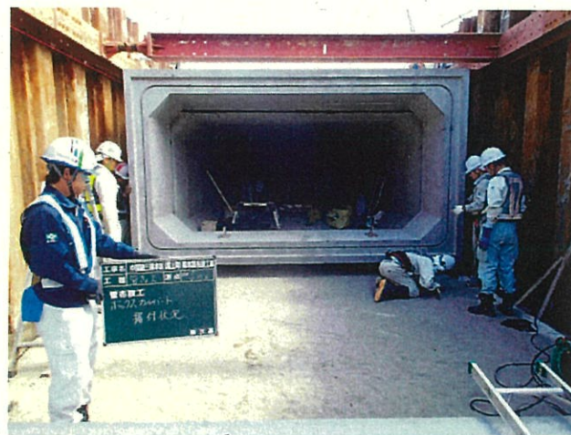
雨水貯留管据付状況
