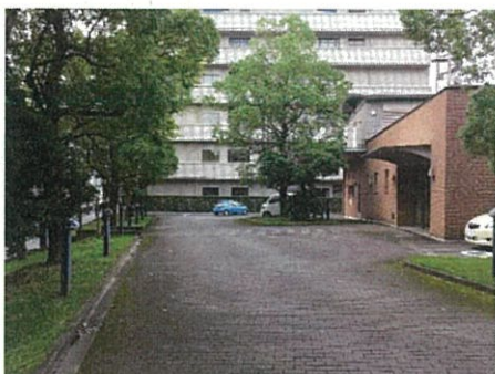
③ 駐車場内部分
