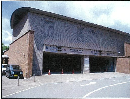
a 茂里町地下駐車場
