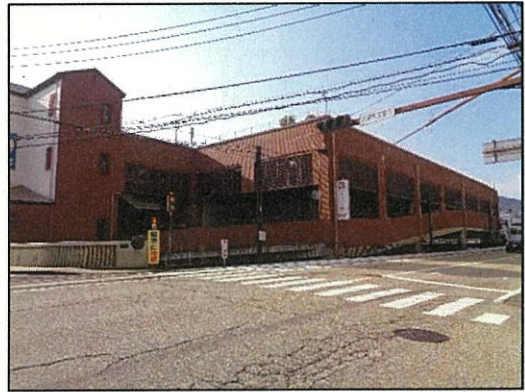
東側（電気軌道側から望む）
