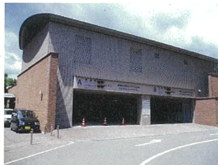
② 茂里町地下駐車場
