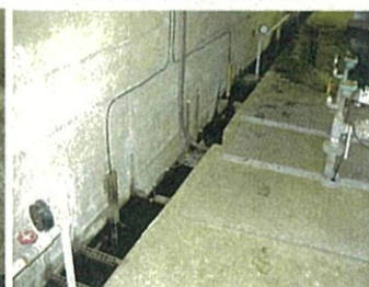
ダム漏水量計
