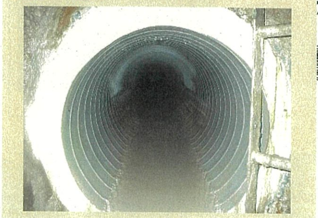
更生工 施工後
