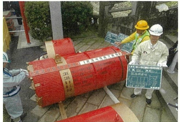
H26年度施工時の掘進機
