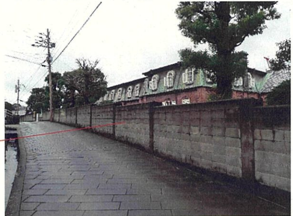
<マリア園ブロック塀>
