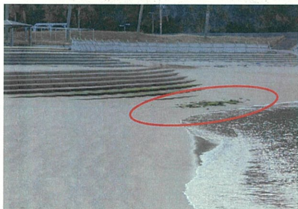
③ (砂浜) 風浪等による砂の減少 (捨石の露出)
