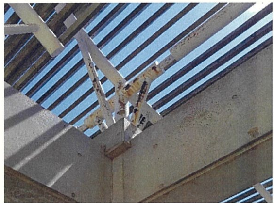
(管理棟上屋 一部拡大)
