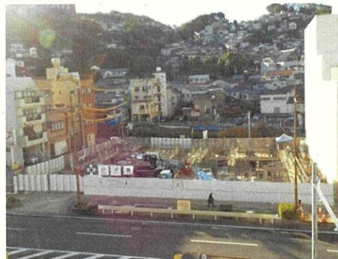
南街区 (建物基礎工事中)
