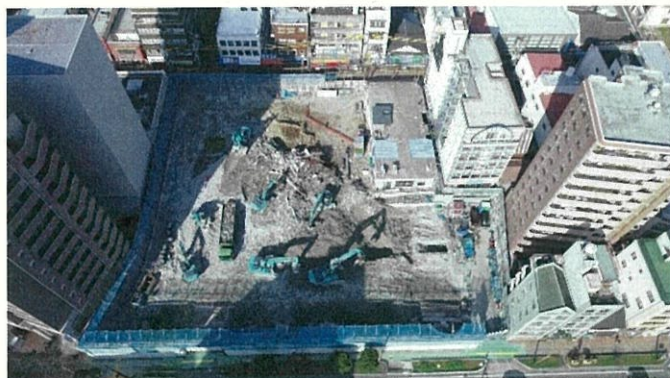
北街区 (既存建物解体中)
