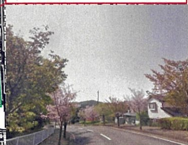
園路改修 L=70m
