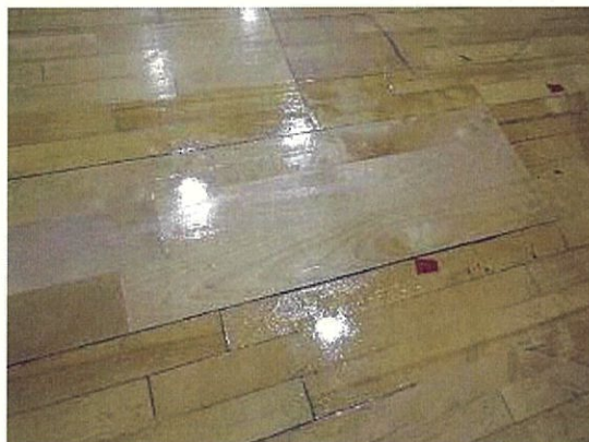
部分補修状況
