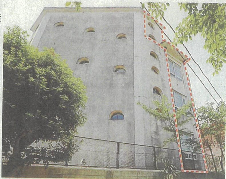
保存されている旧城山国民学校校舎。正面が階段棟。右の四角い窓があるのが教室棟。点線で囲った部分が戦後、建て直されたことが分かった ※長崎市（荒木勝郎撮影、画像は一部加工）
