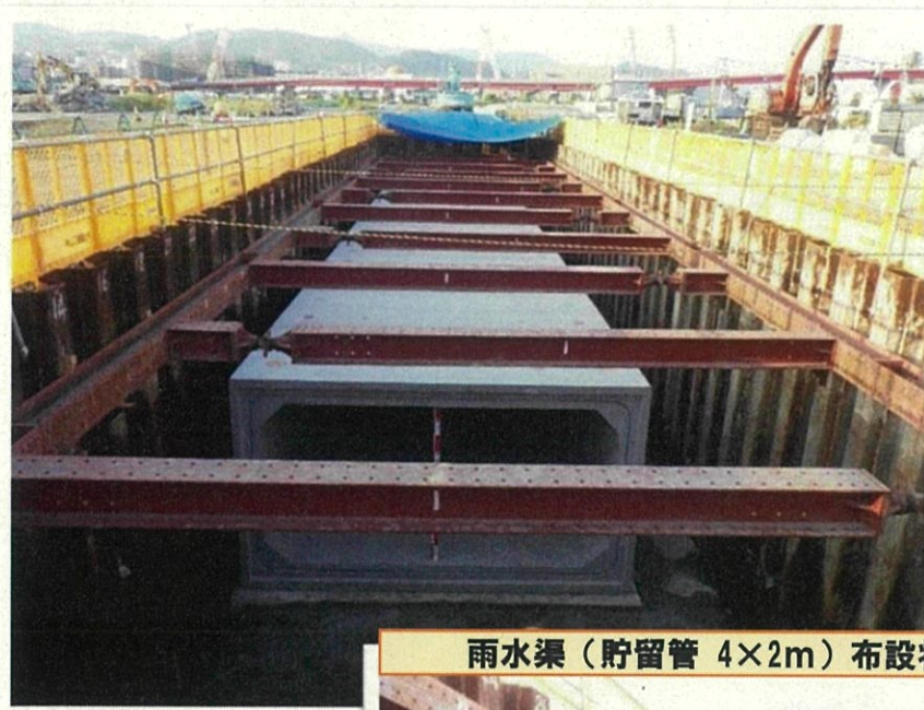
【開削工法】地面の上から直接掘削する一般的な工法
