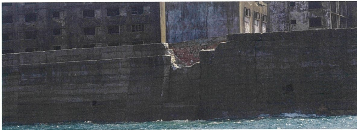
西側護岸崩落状況
