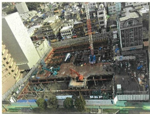
北街区(基礎工事中)
