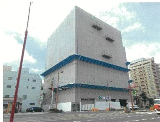
南街区(内装工事中)
