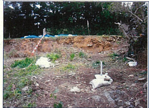
滑落崖状況 (H30調査)
