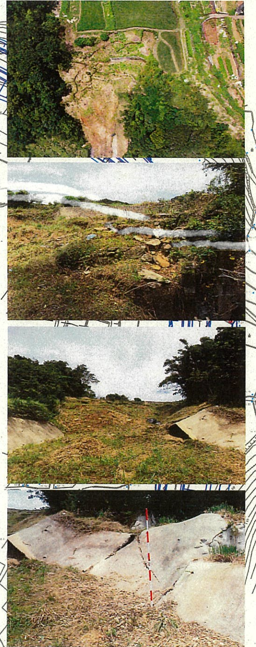
ブロック② 状況写真
