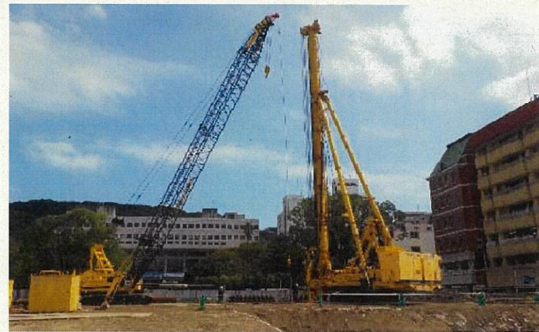
山留工事重機
