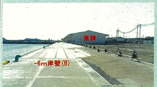
撮影：令和3年1月（-6m岸壁(B)）
