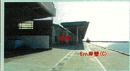
撮影：令和3年1月（-6m岸壁(C)）
