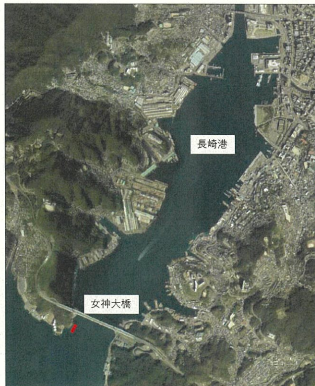
浚渫箇所(航空写真)
