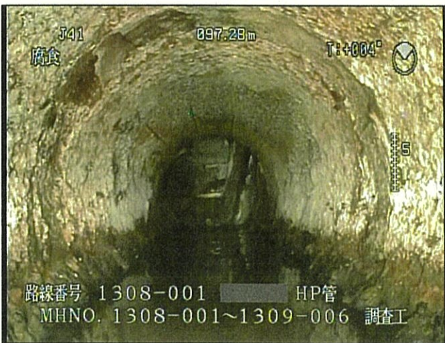
管更生 施工前
