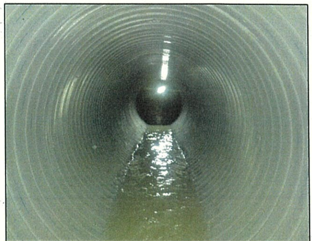
管更生 施工後
